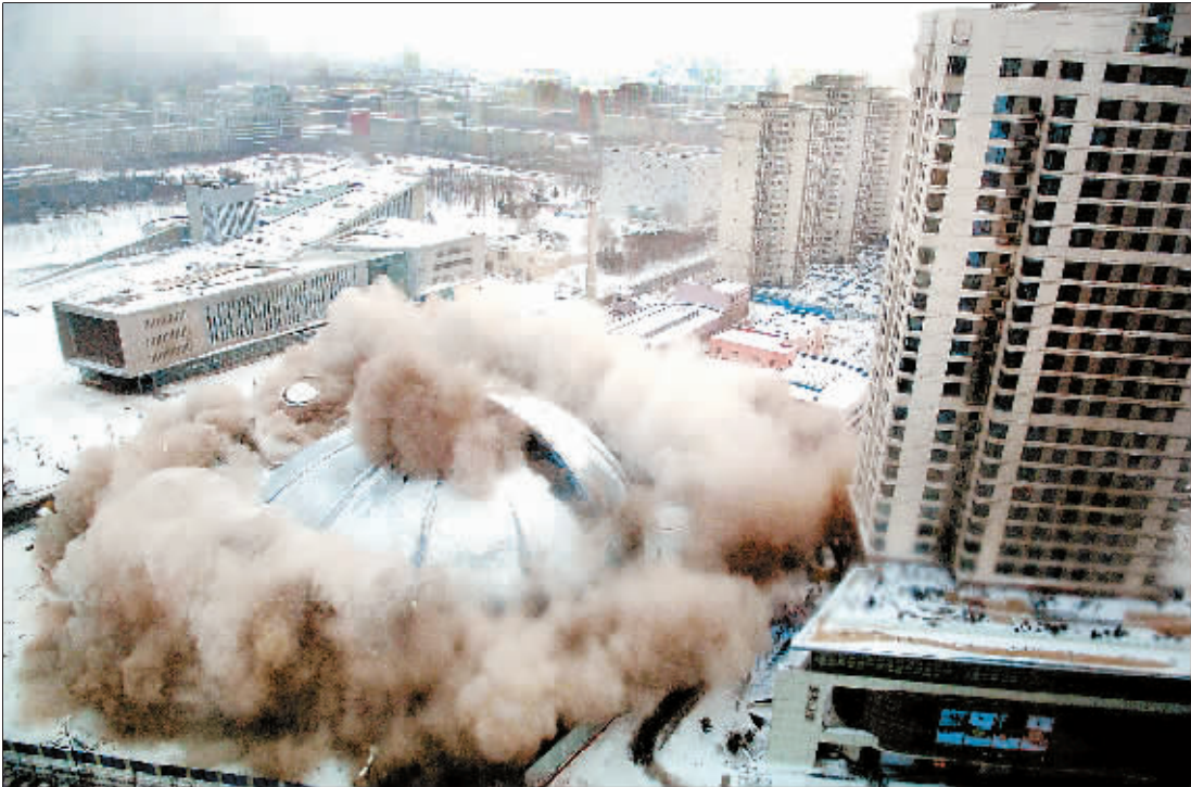
近日，沈阳的标志性建筑“夏宫”被爆破拆除。这座投资2亿元，于1994年建成的沈阳市民水上娱乐中心曾经是上个世纪90年代我国著名的拱体建筑。被爆破拆除后，“夏宫”原址将用于房地产开发。图为沈阳“夏宫”被爆破拆除的瞬间。
