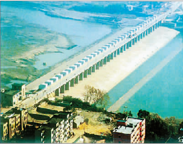
加固后的荆江分洪南闸
