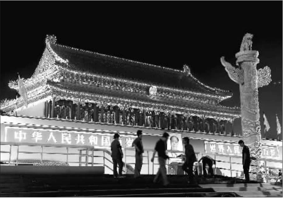
9月14日,首都国庆节景照明设施试亮灯。据了解,为迎接新中国成立60周年,北京市共有14项21个夜景照明设施进行了改造新建。图为工人在天安门城楼前的临时观礼台施工。新华社记者 罗晓光 摄
