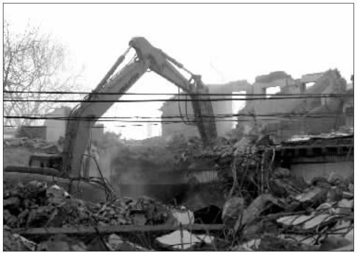
1月14日，一辆掘土机正在北京菜市口东南地段破拆老建筑，距掘土机不足100米，就是有着200多年历史的便宜坊烤鸭老店。这栋见证了历史沧桑的老楼，正在掘土机的强大震撼下摇摇欲坠。
