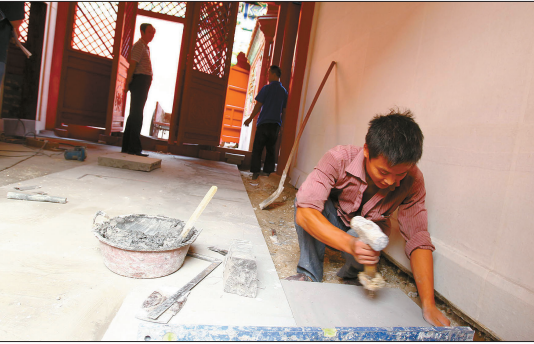
慈宁宫室内维修现场
