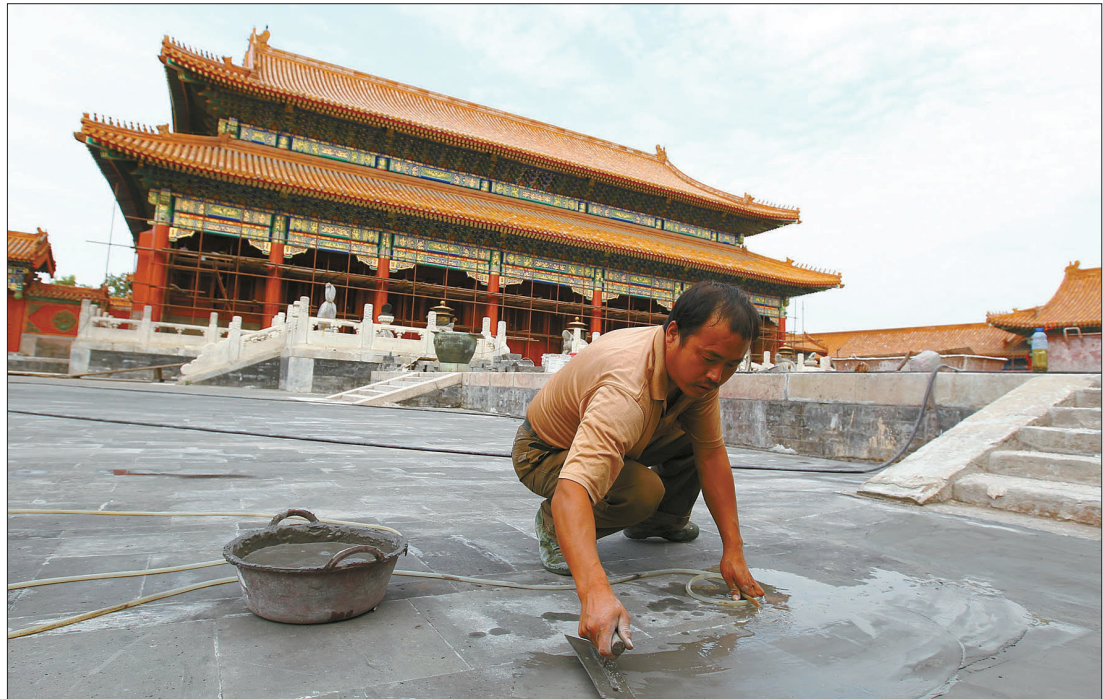
慈宁宫维修现场
