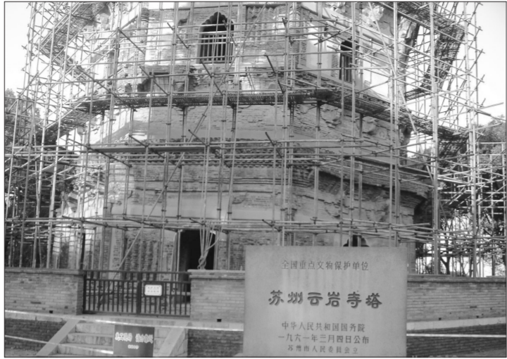
正在检修的虎丘塔
