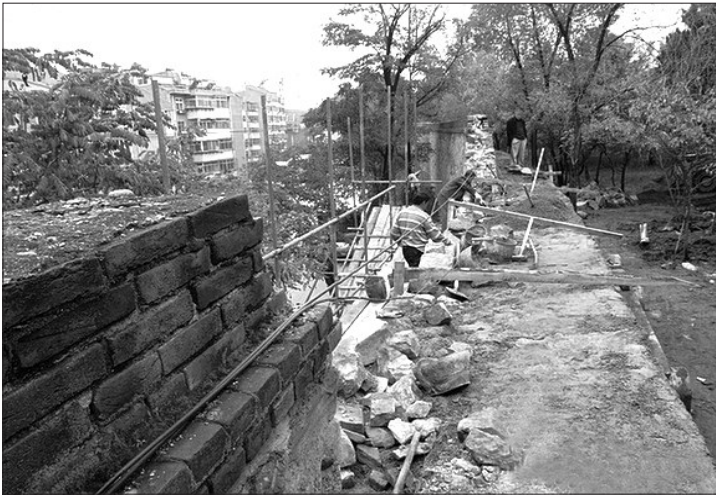
避暑山庄周围寺庙修缮工程正在紧张施工。 李建成 摄
