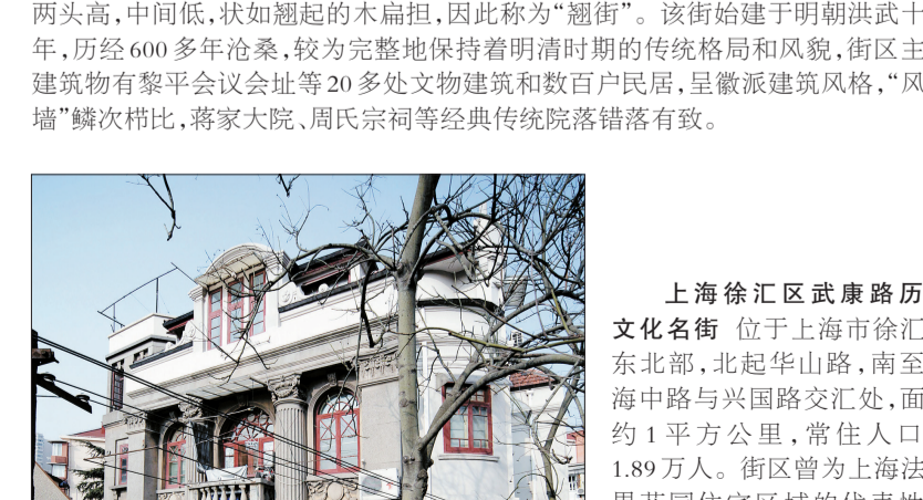
上海徐汇区武康路历史文化名街 位于上海市徐汇区东北部，北起华山路，南至淮海中路与兴国路交汇处，面积约1平方公里，常住人口约1.89万人。街区曾为上海法租界花园住宅区的代表性路段，不同建筑风格集聚，名人故居众多，文物古迹丰富，体现了上海近代高级住宅区的建筑、环境、人文和城市空间品质，为上海中心城区最具欧陆风格街区之一。
