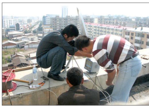
基层工作人员在安装共享工程设备
