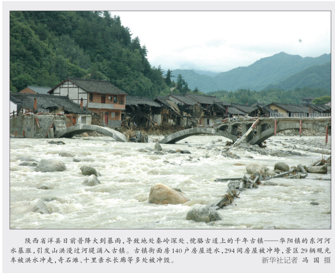
陕西省洋县日前普降大到暴雨，导致地处秦岭南麓、汉江上游的千年古镇——华阳镇的东河河水暴涨，引发山洪漫过河堤涌入古镇。古镇街面房140户房屋进水，294间房屋被冲垮，景区29辆观光车被洪水冲走，奇石滩、十里亲水长廊等多处被冲毁。新华社记者 冯国摄
