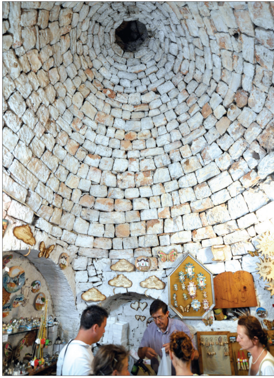
阿尔贝罗贝洛是意大利普利亚大区巴里省的一个小城,城内的圆顶石屋建筑技术中无灰泥建筑技术的典型代表,该技术在这一地区仍然沿用。圆顶石屋由从附近采集来的石灰石石块粗糙堆砌而成,撑起金字塔形、圆锥形或球状的屋顶,这种独具特色的建筑群吸引着来自世界各地的游客。
