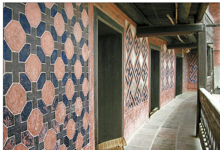
位于漳州市华安县仙都镇的二宜楼兼有客家内通廊式土楼和闽南单元式土楼的双重特点,墙上的部分雕刻还颇具伊斯兰风情。
