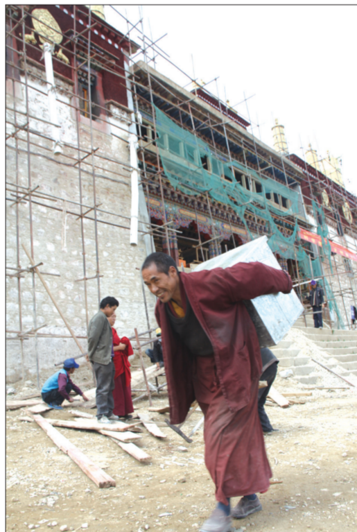
哲蚌寺果芒扎仓维修现场
