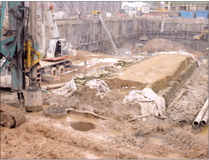
5月4日,长沙古城墙部分遗址迁移工程已完成。施工人员正在对保留的20米古城墙周边“旋挖桩”浇注混凝土。文卫 摄
