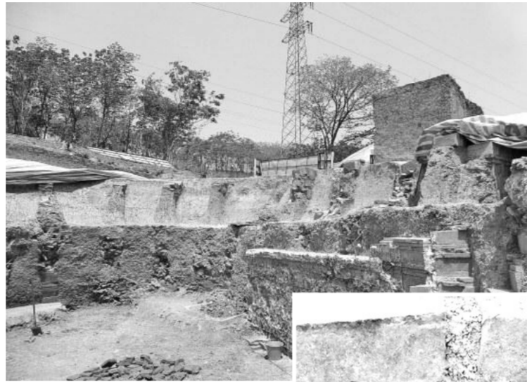
▲永宁陵施工工地
