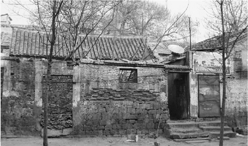
部分墙体已开裂、脱落的徐州户部山古民居。
