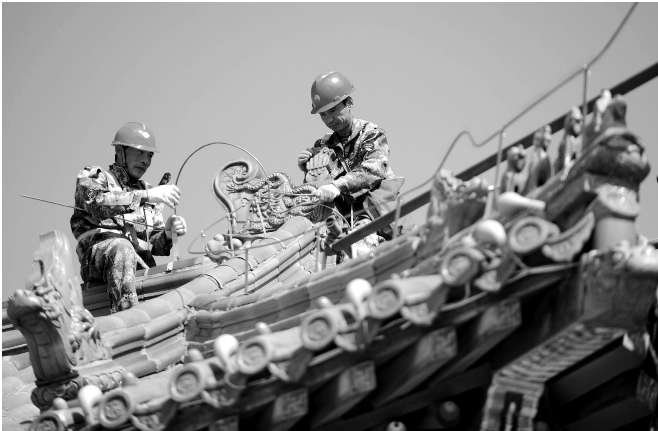
4月6日,世界文化遗产——沈阳昭陵避雷工程正式启动,工程为期3个月。施工人员将为沈阳昭陵内古建筑更换紫铜材料防雷带。此次施工采用简便、高效、安全的新型焊接工艺,同时将设置170多处新型接地装置,可将雷电更好地导入地下。图为当日,施工人员在沈阳昭陵古建筑上安装防雷带。 新华社发(张文魁 摄)
