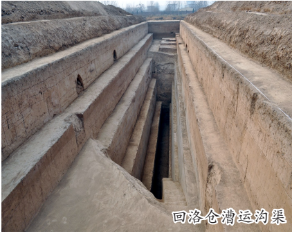
回洛仓滑运沟渠
