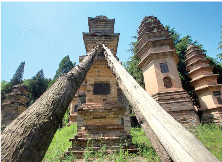
为了防止古塔倒塌，有关部门用树桩顶住塔身，个别高危的古塔，需要用三根树桩进行固定。在塔林内，这样的古塔，多达20余座。（资料图）
