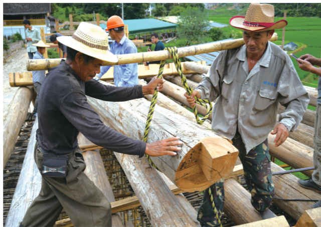
文兴桥修复现场
