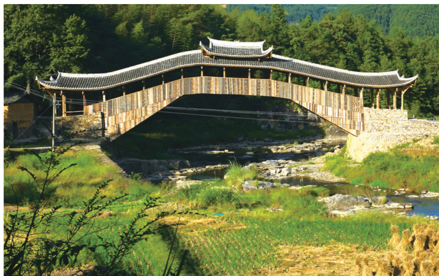
修复保护工程完成后的文兴桥
