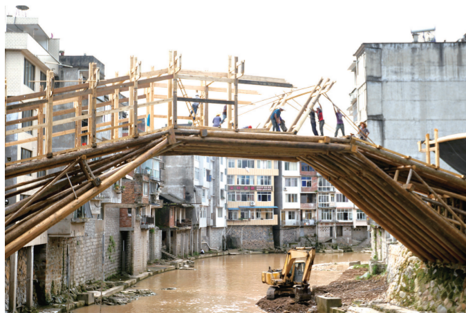
薛宅桥修复现场
