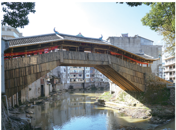
修复保护工程完成后的薛宅桥
