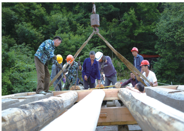
文重桥修复现场
