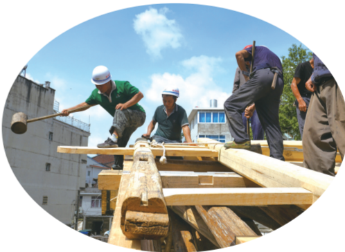
传承人在施工
