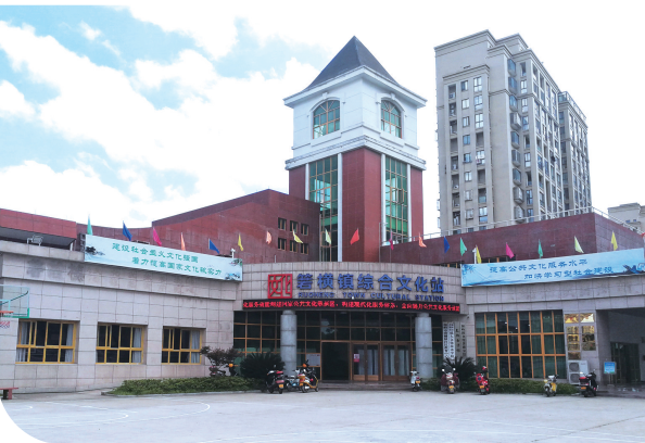
温岭市箬横镇综合文化站外景
